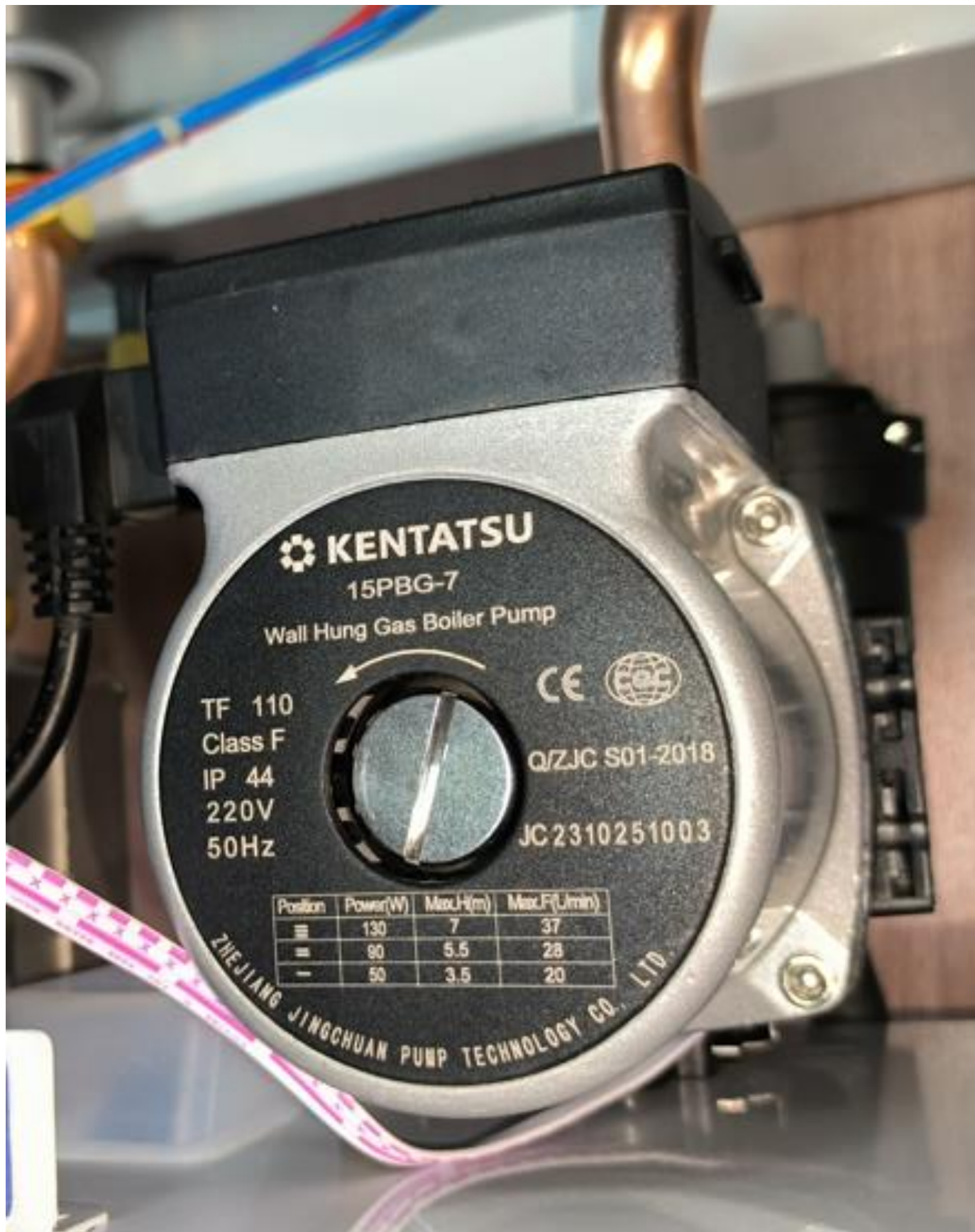
Циркуляционный насос Kentatsu. Base.
